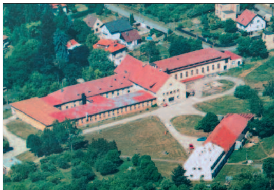
Hradištko - letecký pohled na objekt tiskárny.
